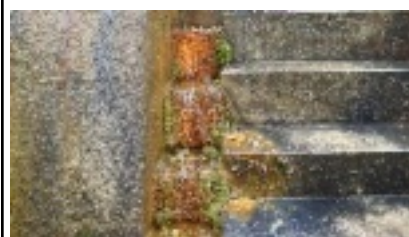
虹ヶ丘団地階段部分
