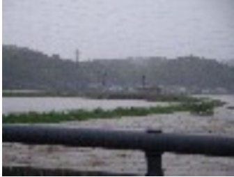
中川原橋から 遠賀川の氾濫寸前
